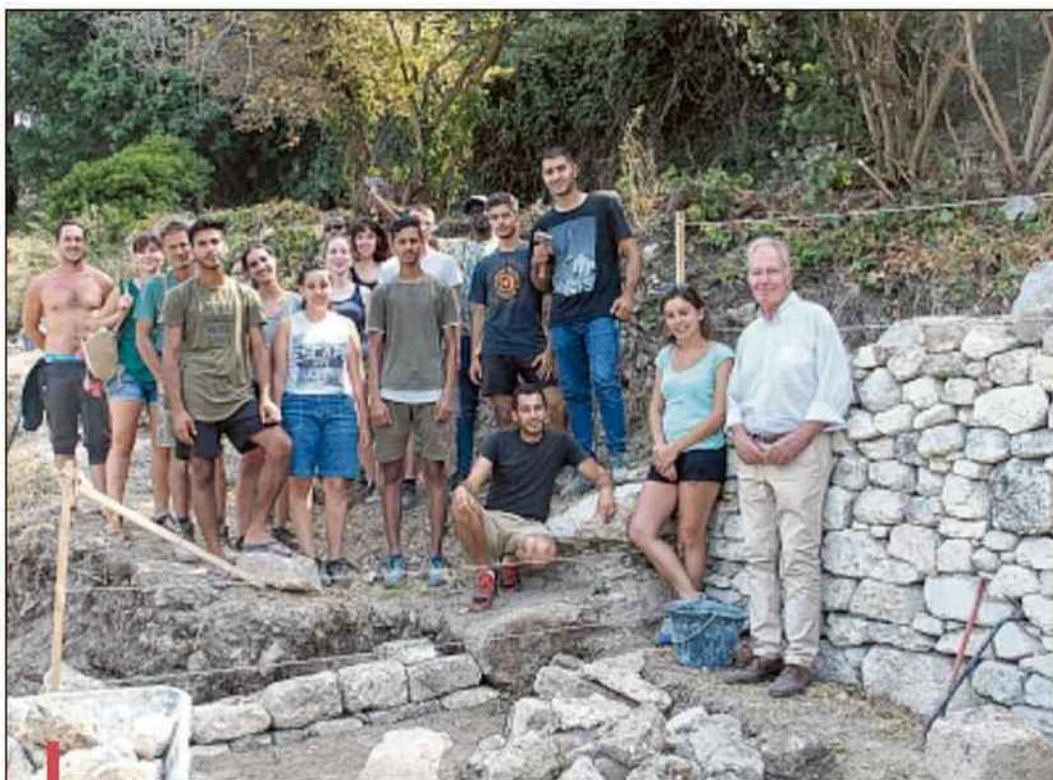
Onze bénévoles participent à ce chantier organisé par l'APARE-CME. Ensemble, ils restaurent les restanques sous le château, à la grande satisfaction du maire.
